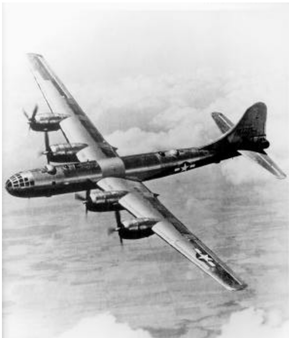
Volant à 10 000 mètres à près de 600 km/h, le Boeing B-29 Superfortress fut le bombardier à long rayon d'action employé de 1944 à 1952. Deux d'entre eux, baptisés « Enola Gay » et « Bock's Car » ont largué les bombes atomiques Little Boy et Fat Man sur Hiroshima et Nagasaki. Un total de 3 970 appareils a été construit. (Cliché Keystone).
